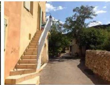
Le mur nord à conserver
